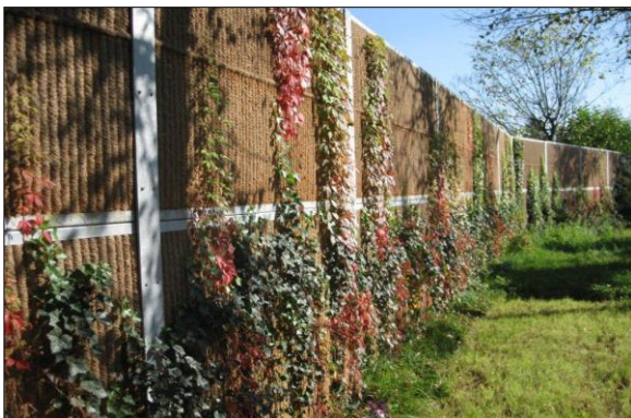
Kokowall Lärmschutz 3,5m hoch N317 in Doetinchem
