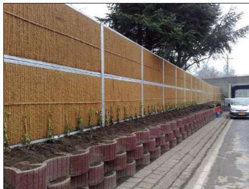
Kokowall Lärmschutzwand in Weert H=3m, l=50m
