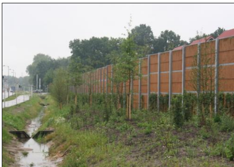
Kokowall Lärmschutzwand te Enschede, l=200m 5m hoch.
