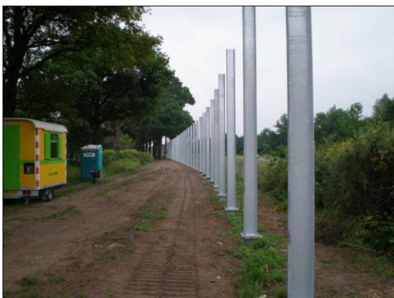
Montage und setzen Pfosten
