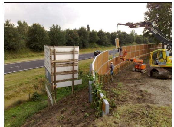
Hoben und montieren der Elementen
