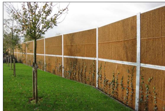
Kokowall Lärmschutz 3,5m hoch in Berkel en Rodenrijs
