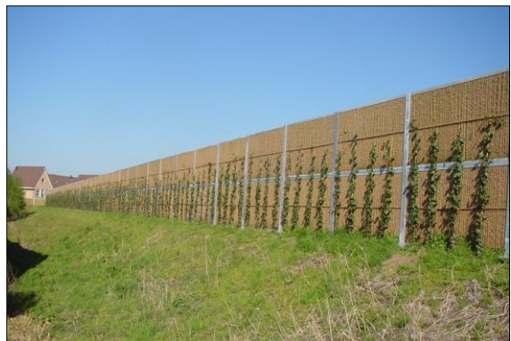
Kokowall Lärmschutz 2,5m hoch, länge 455m in Barneveld
