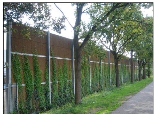
Kokowall Lärmschutzwand in Vianen, l=200m, 3-6m hoch
