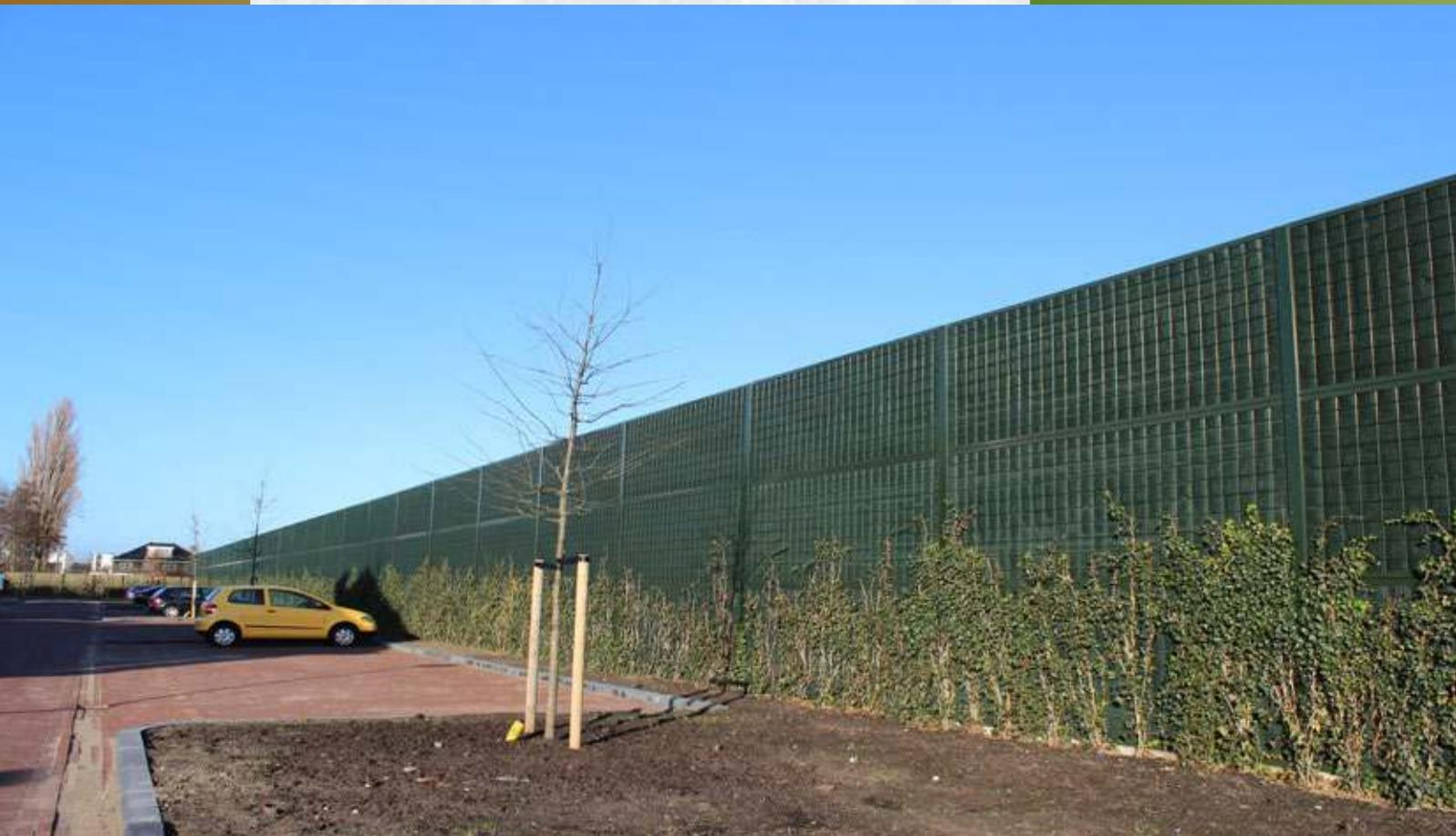
*Die Noise-Reducer® Schallschutzwand ist eine leichtgewichtige Konstruktion mit einem hohen Isolations- und Absorptionswert. Die Außenseite dieser Schallschutzwände ist auf einer der beiden Seiten mit einer Schicht absorbierender Mineralwolle versehen, die mit mehreren Gitterschichten bekleidet ist.*
