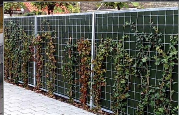
Die Kokowall® LITE Lärmschutzwand ist eine leichte Konstruktion mit einem hohen Isolationswert. Die Außenseite der Wände besteht auf einer Seite aus natürlichen und langlebigen Kokosfasern. Neben einer schönen Ausstrahlung bieten Kokosfasern einen idealen Untergrund für verschiedene Kletterpflanzen. In wenigen Jahren ist eine Kokowall® Lärmschutzwand vollständig begrünt.
