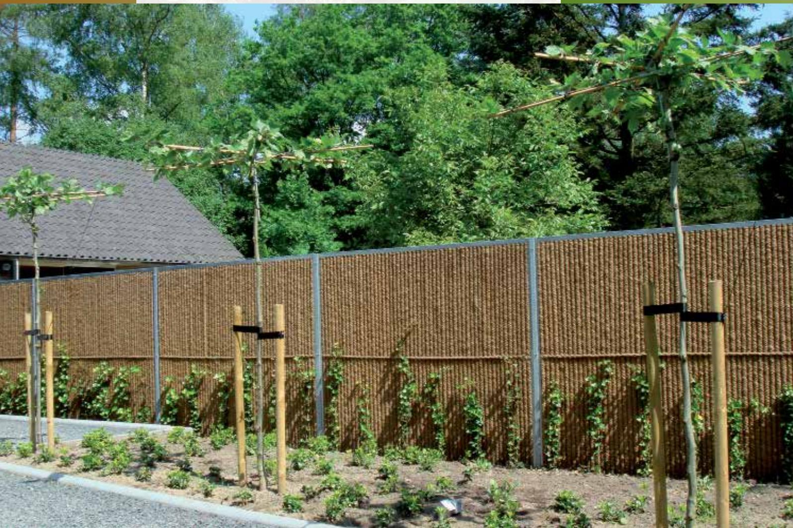
*Eine warme Ausstrahlung, die in jede Umgebung passt. Das sind die kennzeichnenden Merkmale der Kokowall® Lärmschutzwände. Kokowall® ist eine für die Begrünung geeignete Lärmschutzwand, deren Außenseite aus langlebigen Kokosfasern besteht. Neben einer erheblichen Geräuschabsorption bieten Kokosfasern einen idealen Untergrund für verschiedene Kletterpflanzen. In wenigen Jahren ist eine Kokowall® Lärmschutzwand vollständig begrünt.*
